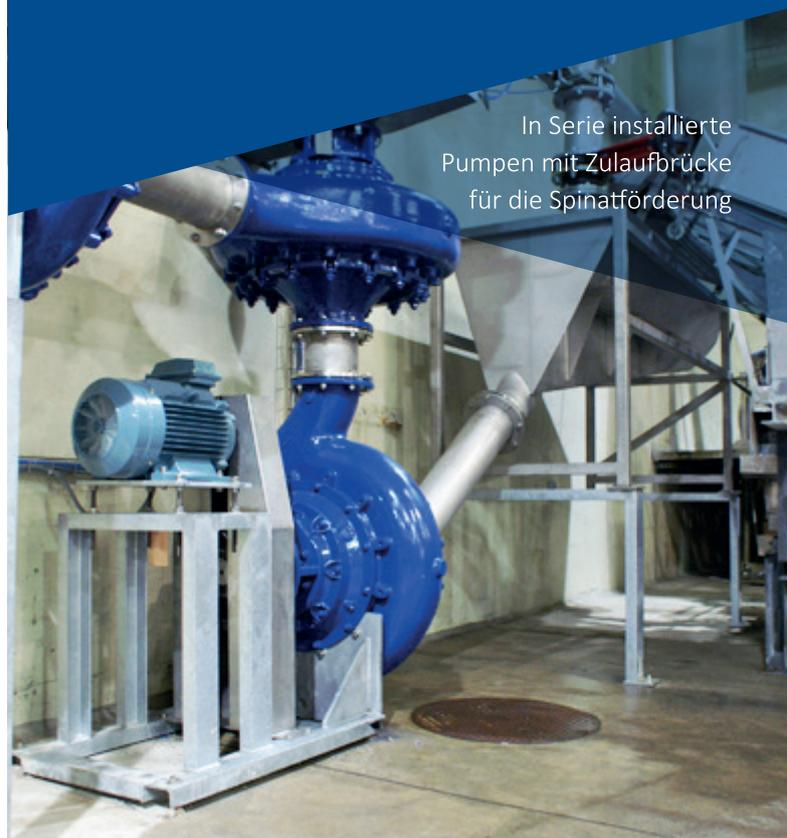
In Serie installierte Pumpen mit Zulaufbrücke für die Spinatförderung
